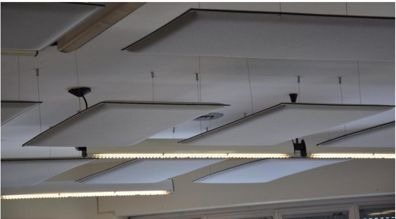
*Esempio pannelli fissati a soffitto in orizzontale con kit di appensione*
